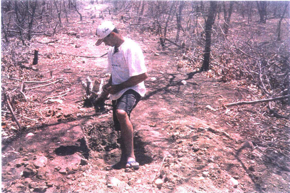
Foto 3 - Sondagem à pá/picareta na estaca 07 no eixo da barragem.
