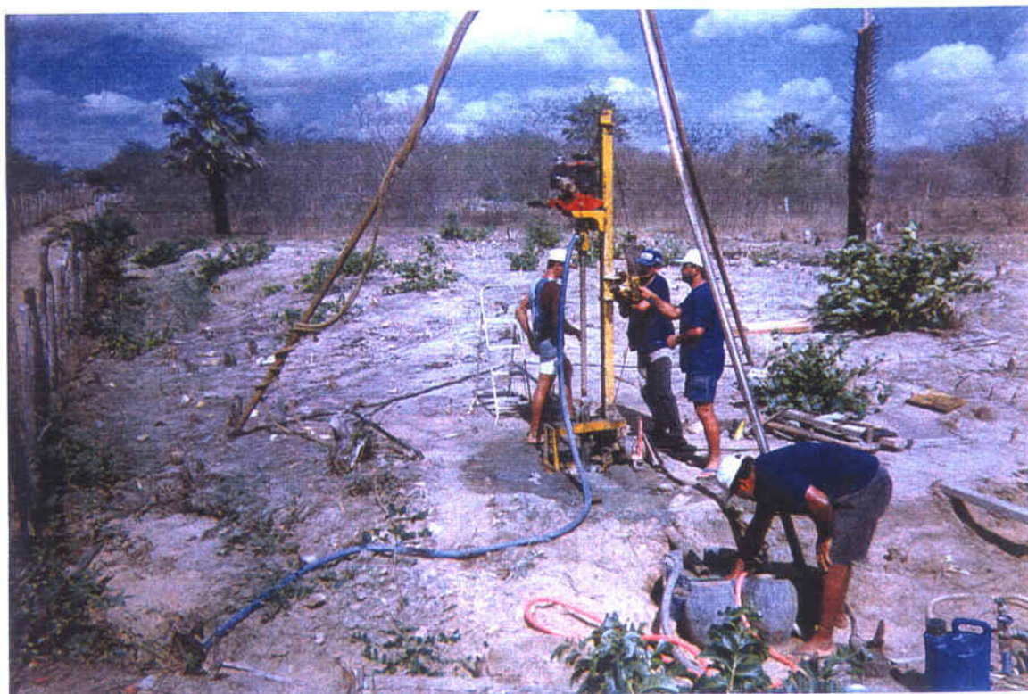
Foto 14 - Equipe em trabalhos da sondagem rotativa SR-03.
