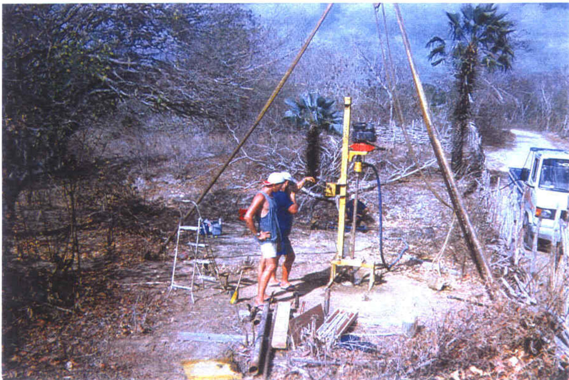
Foto 13 - Equipe em trabalhos da sondagem rotativa SR-01.
